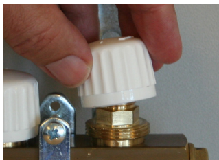
Afmonter det nederste håndgreb
