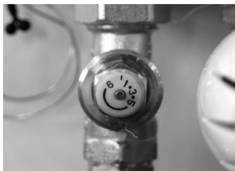
Indregulering foretages på forindstillingsskruen.
