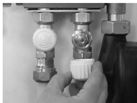
Gulvslangen vandfyldes fra anlægget ved at åbne termostatventilen.
