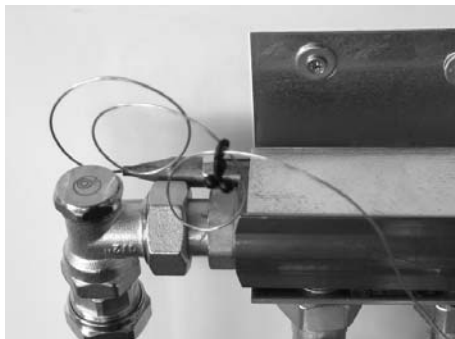
Føleren anbringes mellem blanderør og ophængsbeslag.
