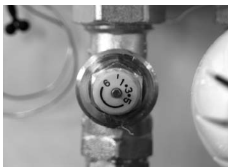
Indregulering foretages på forindstillingsskruen.
