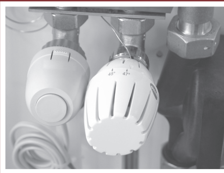
Telestaten tilsluttes styreenheden.
