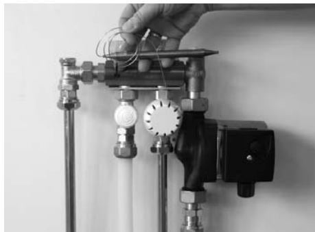
Følelement for termostatventil.
