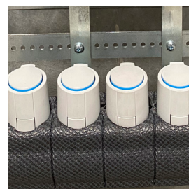
Max. bestyknig af et BUNDMODUL for at det kan være i et 60 cm skab. 12 GV, 16KV og 9VV.
