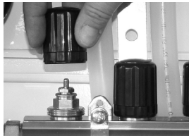
Afmonter det nederste håndgreb
